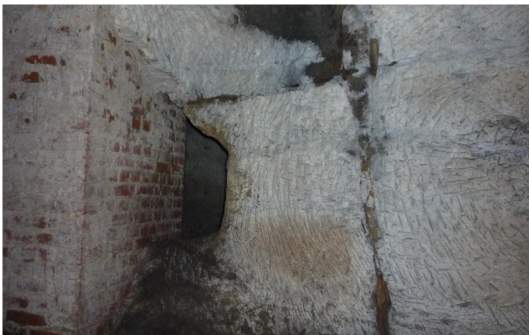
Foto č. 23 – Sklep D, opěrný pilíř, vpravo výrazná puklina.
