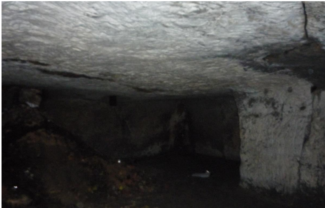
Foto č. 14 – Sklep B, ve stropu vpravo výrazná puklina.
