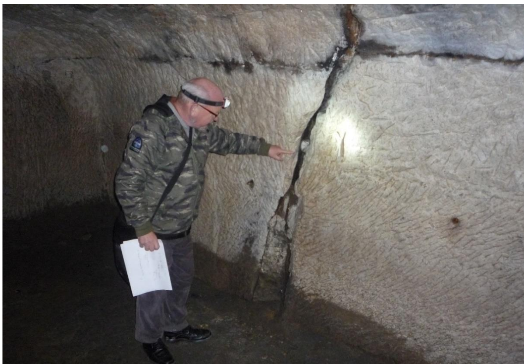
Foto č. 25 – Sklep D, výrazná subvertikální dislokace.
