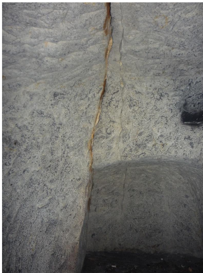
Foto č. 48 – Sklep F, subvertikální puklina.
