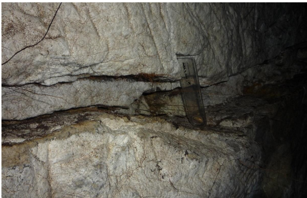
Foto č. 28 – Sklep E, výrazná rozevřená dislokace ve stropu.
