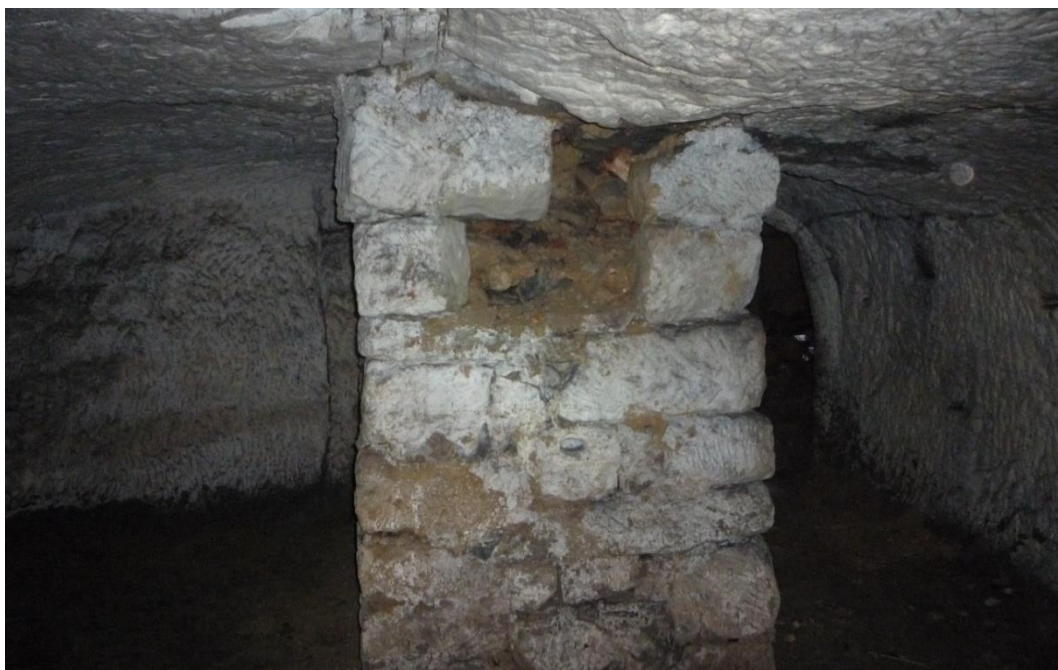
Foto č. 29 – Sklep E, částečně porušený opěrný pilíř.
