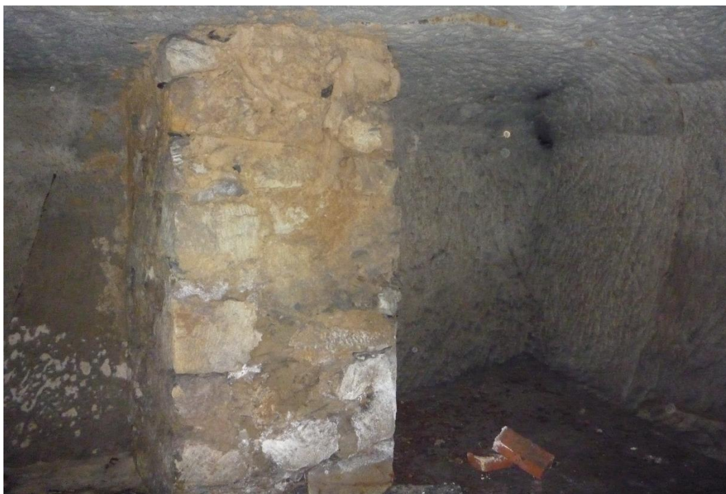
Foto č. 47 – Sklep F, zděný opěrný pilíř.
