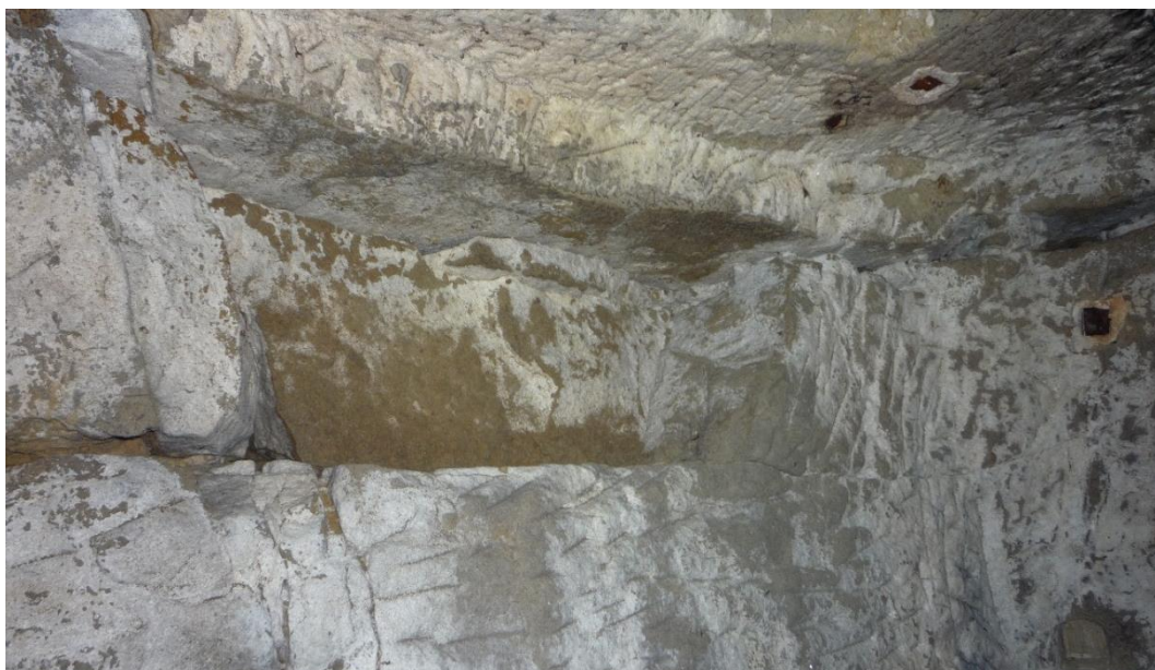
Foto č. 15 – Sklep B, výrazná subhorizontální vrstevní spára.
