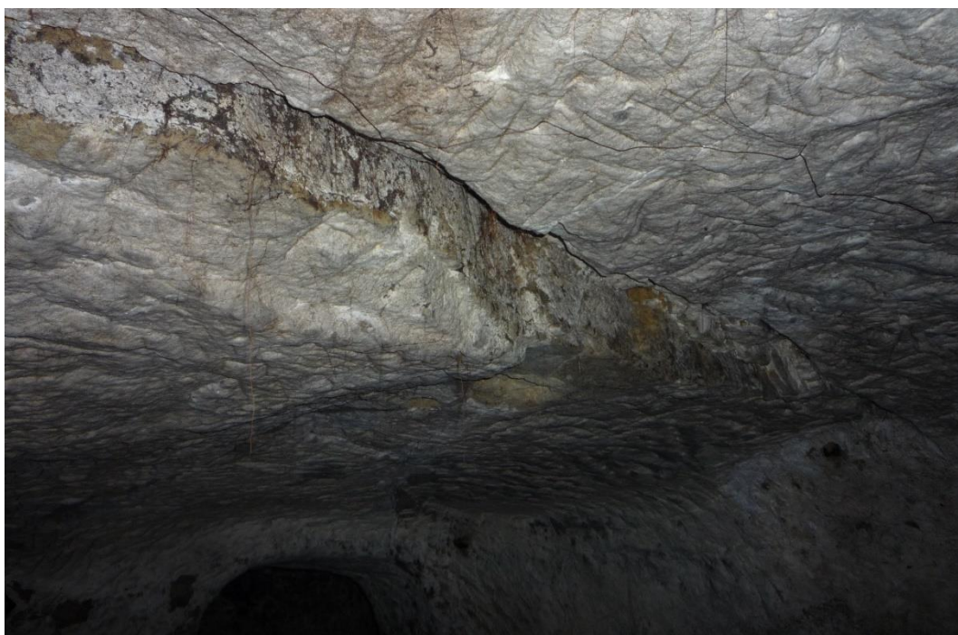
Foto č. 27 – Sklep E, pokles horninového bloku o cca 15 cm.
