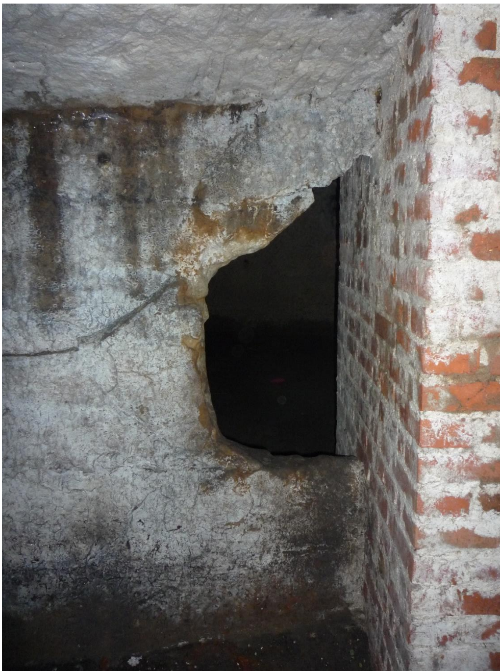
Foto č. 18 – Sklep C, zděný opěrný pilíř.
