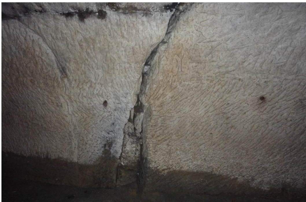
Foto č. 49 - Rozevřená subvertikální puklina ve stěně sklepa F.
