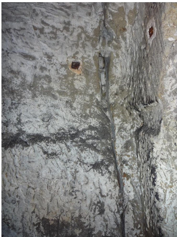
Foto č. 16 – Sklep B, výrazná subvertikální puklina.
